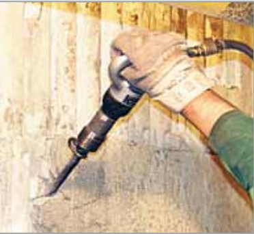
Semplice rimozione di intonaco e piastrelle
